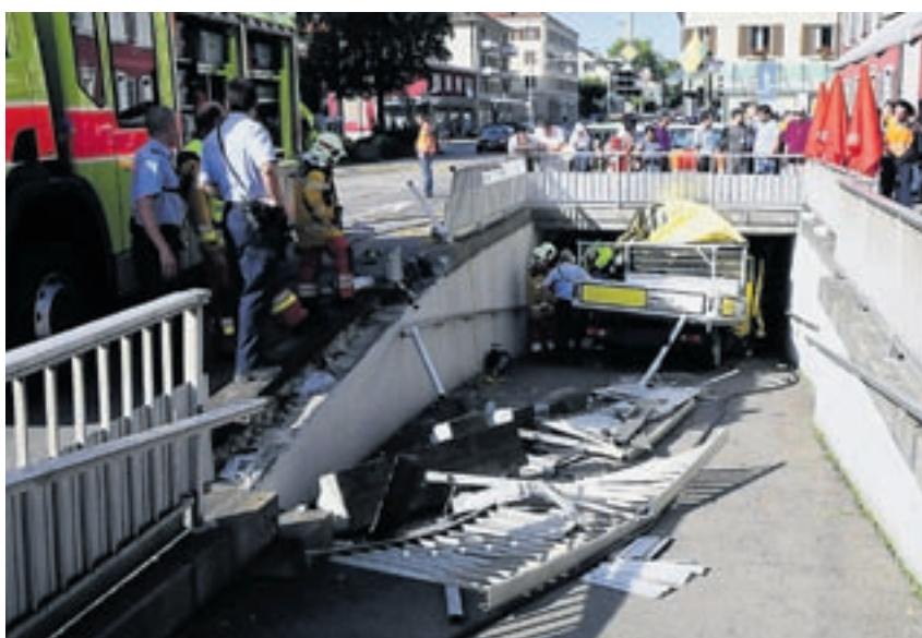
Der Wagen durchschlug das Geländer und fuhr in die Decke der Unterführung. Bild: pd
